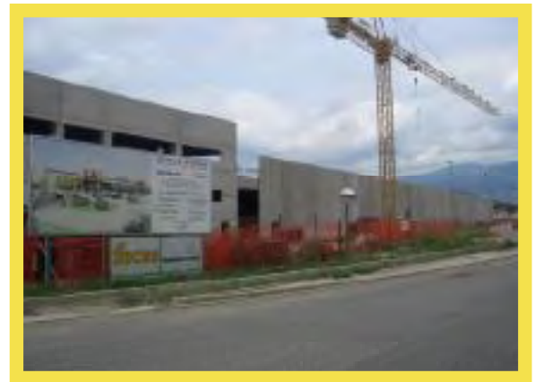
Cantiere Centro Commerciale
