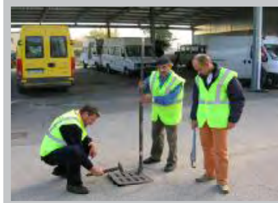
Operai al lavoro
