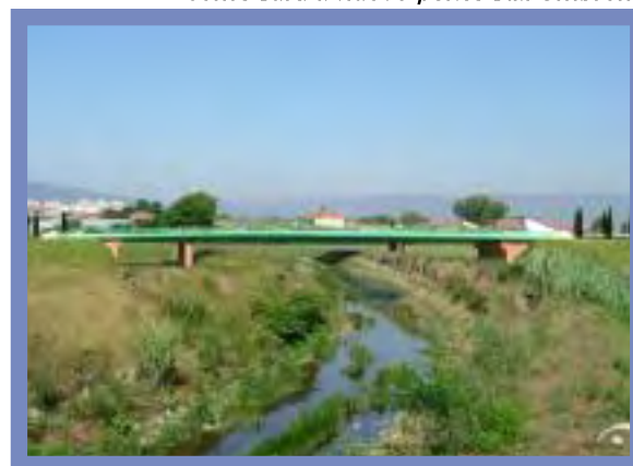
Il ponte visto da est
