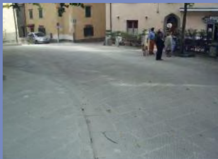
Pavimentazione nuova della piazza
