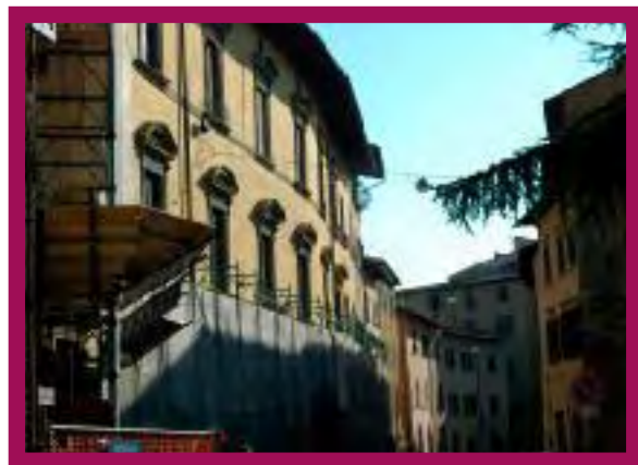
Palazzo Fabroni in ristrutturazione
