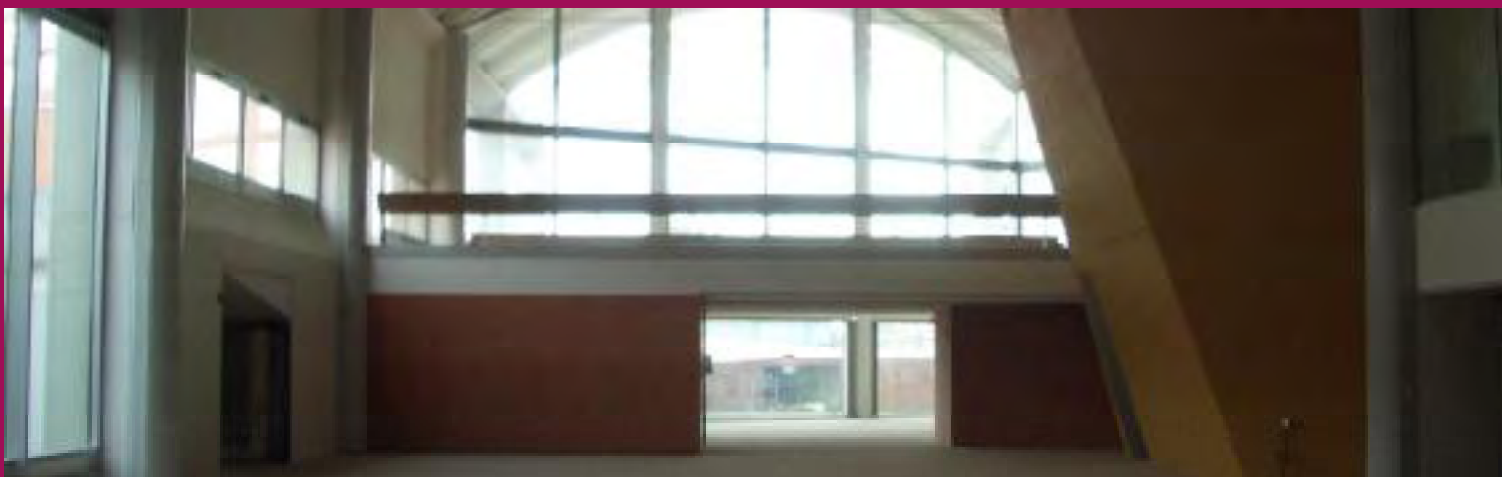
La nuova biblioteca in costruzione
