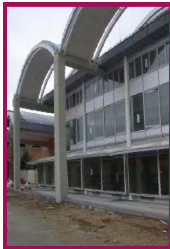
La nuova biblioteca in costruzione
