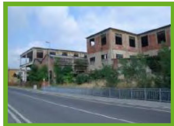
Vista dei capannoni nei quali sorgerà l'albergo
